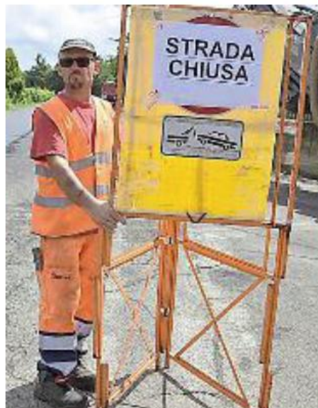
Dopo l'estate aprono numerosi cantieri per le asfaltature
